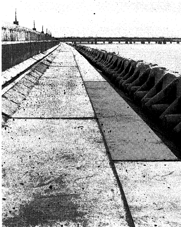
▼ 新淀川の河口部特殊堤、階段状に建設されている。
