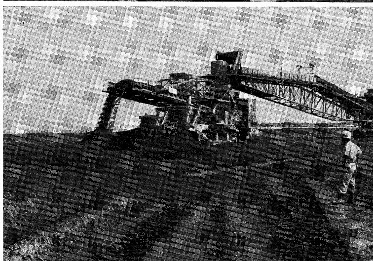
鹿島港において建設中であった土砂輸送用ベルトコンベアが完成し、昭和 46 年 4 月から土砂輸送を開始した。このコンベアは、仮置場に集積されたポンプしゅんせつ船による南航路・北航路等のしゅんせつ土砂を南海浜土捨場まで輸送するために設置されたものであり、全長約 8 km の土木工事用コンベアとしてわが国最長の規模を有し、3 年間で約 2 200 万 m<sup>3</sup> の土砂を輸送する計画である。主コンベアは 5 本で構成され、ベルト幅 1.2 m・走行速度 300 m/min・輸送能力 2 400 m<sup>3</sup>/h である。
