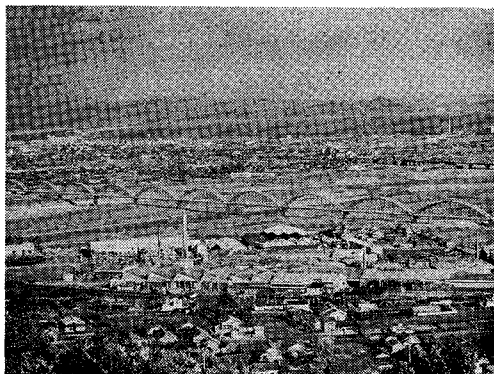
富士川水管橋
