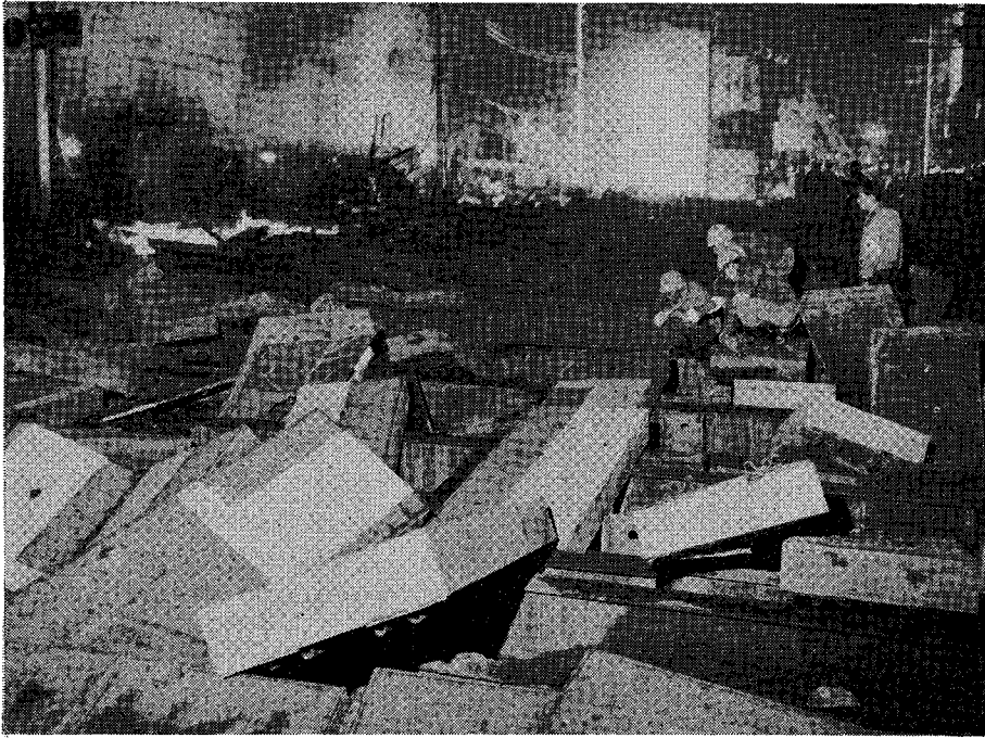
(昭和 45 年 4 月 8 日発生, 写真・共同 P 提供) 大阪のガス爆発現場の惨状
