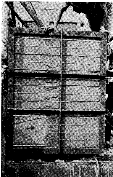
写真—6 切羽崩壊状況
