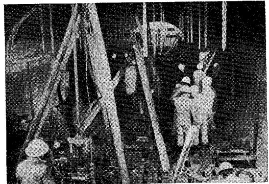
地下鉄千代田線工事現場にて
