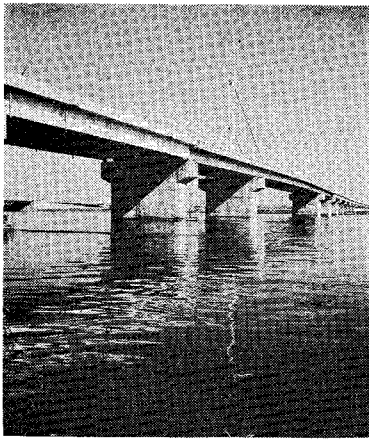
写真-2 荒川大橋
