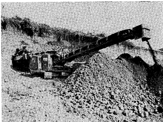
写真-2 稼働中のホイールエキスカベーター
