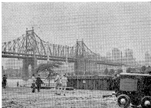
写真—2 63 RB 通りの地下鉄工事現場 (クイーンズ側からニューヨーク都心を望む)
