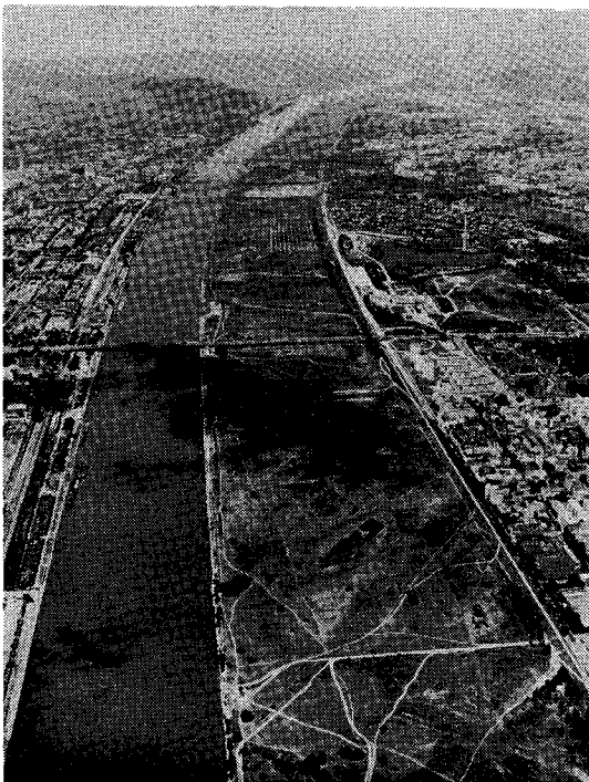
写真-2 ウィーン市洪水防御計画工事の現状
