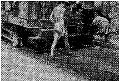
写真-4 アスコンフィニッシャー (イタリア, ユーゴ系の人たち)
