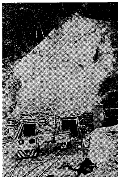
写真-7 親子滝トンネル下坑口
