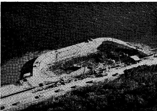
写真-1 施工中の下関側橋脚部
