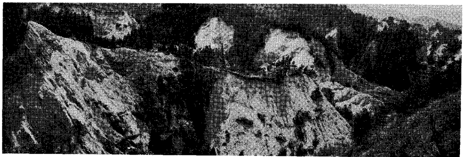
写真—11 えびの地震による山腹の崩壊とその修復の跡
