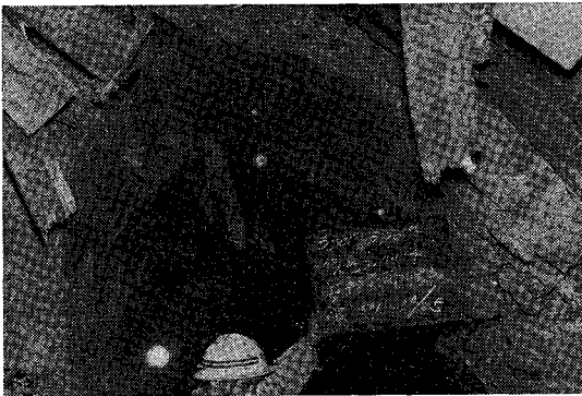
写真-3 導坑仮巻の変状
