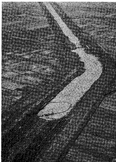
写真-24 ポンプ船により掘削中の篠津運河 (昭和36年)
