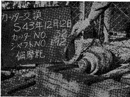
写真-3 カッターの摩耗状況
