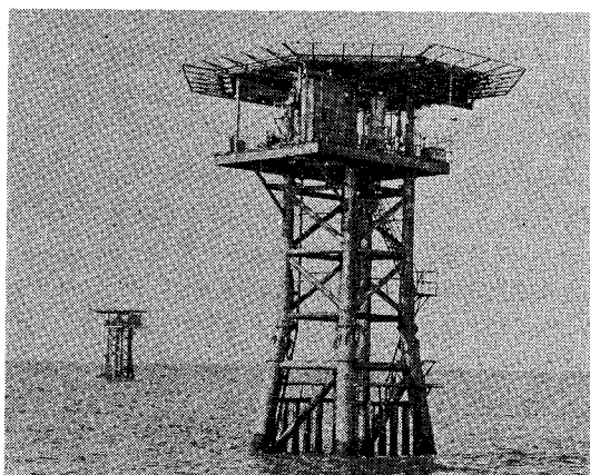
写真-2 秋田県土崎沖油田 油井ジャケット
