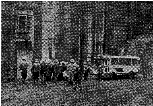
写真-11 高根第一ダム工事現場におりたった参加者
