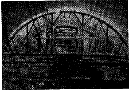
写真—2 施工時の関門鉄道トンネル (上り線のシールド背面)
