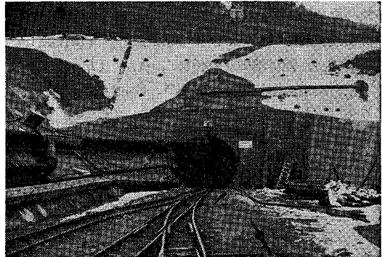
写真-2 タールハイム トンネル坑口
