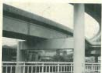
メサコンを使用した 備前高速道路5号線
