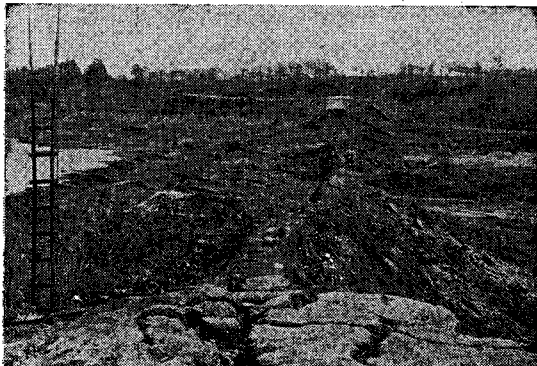
写真-7 早掛沼(むつ市)アースダム崩壊
