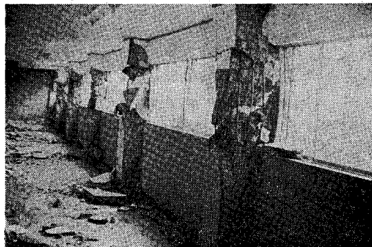
写真-11 鉄筋コンクリート柱の典型的破壊状況
