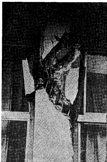
写真-11 鉄筋コンクリート柱の典型的破壊状況
