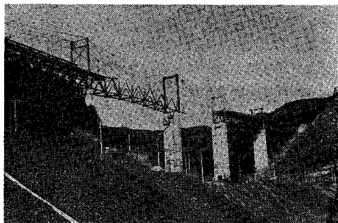
写真-3 中央道の代表的高橋脚橋：底沢橋
