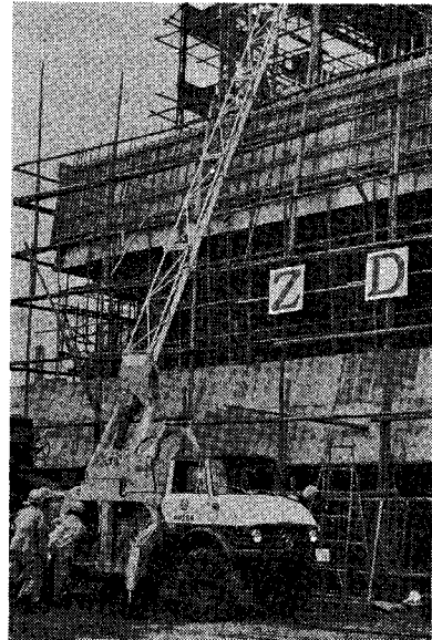
写真-1 ブーム式コンクリートポンプ車
