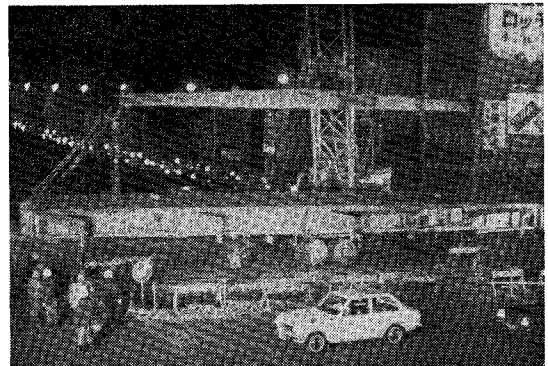
写真-2 大原交差点夜間工事状況
