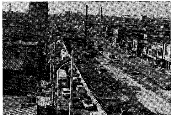
写真-1 大原交差点工事現場
