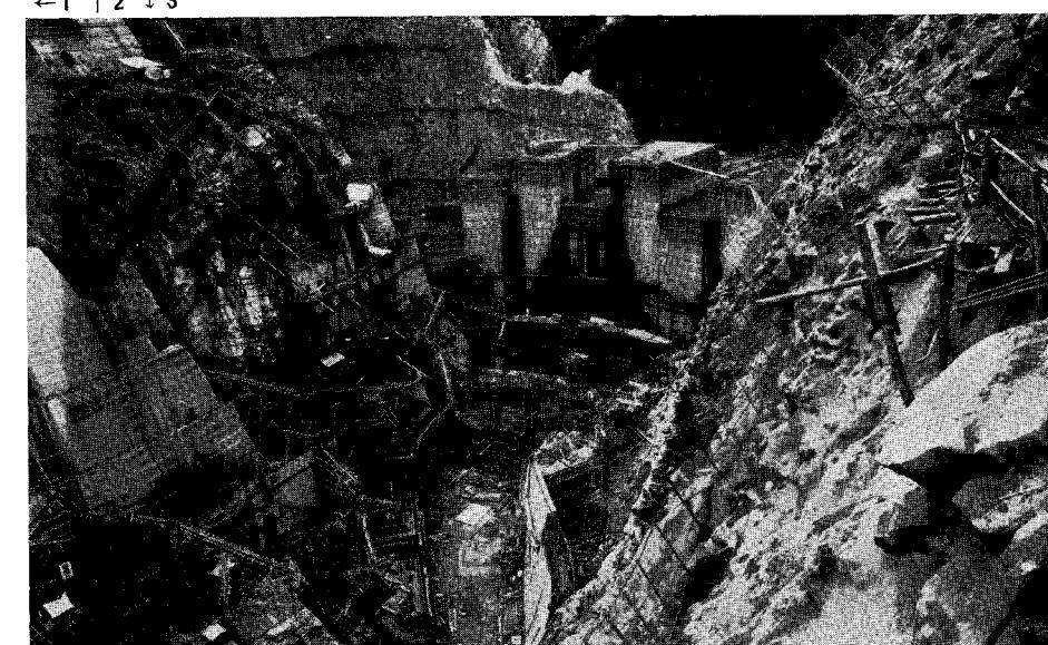
長野県南安曇郡安曇村（左岸）と同奈川村（右岸）地点に建設中の奈川渡ダムは、昭和 43 年 12 月完成を目指し、鋭意工事がすすめられている。同ダムは、高さ 155 m（現在高 75 m）、堤頂幅 10 m、敷幅 35 m、堤体積 672 000 m<sup>3</sup> の巨大なダムで、同所に併設される発電所により 623 000 kW の電力を生むこととなる。発電所関係では、昭和 44 年 6 月にダム直下の発電専用機（1, 2 号機・211 000 kW）の運転を開始、揚水兼用機 3～6 号機（412 000 kW）は、5, 6 号（206 000 kW）を和年 45 年 11 月、3, 4 号（206 000 kW）を昭和 45 年 11 月にそれぞれ運転を開始する予定である。写真一は工事現場全景、写真二は上流側のダム近景、写真三は、ダムの背面およびダム直下の 1, 2 号機発電所放水庭で、左下の方は 3～6 号の揚水兼用発電所を建設しているところである。
