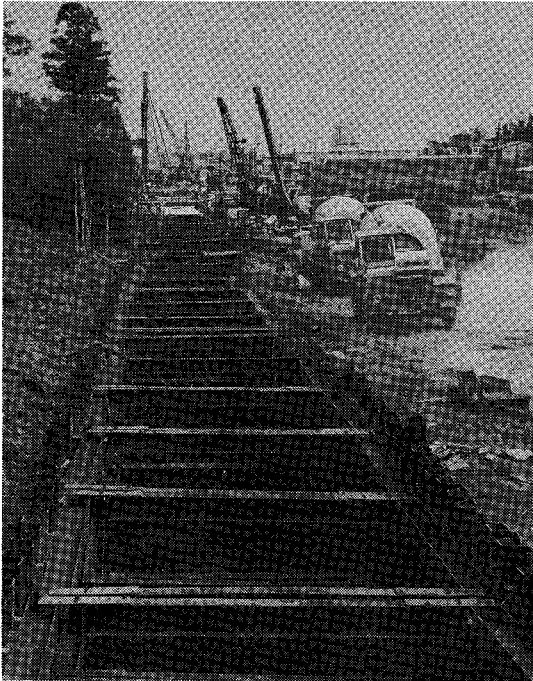
写真一 建設中の荒川左岸流域下水道幹線
