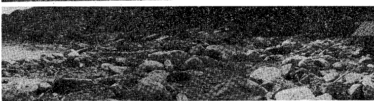
8. 新潟県荒川町 国道113号線か ん没現場
