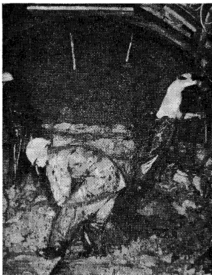
薬液注入により掘削が進められた、朝霞浄水場導水路底設導坑
