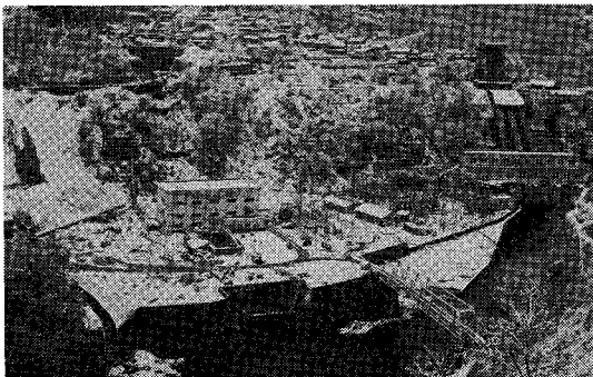
新祖山発電所 (左) と祖山発電所
