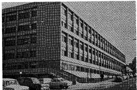
写真-4 ニュールンベルクのアウトバーン建設部
