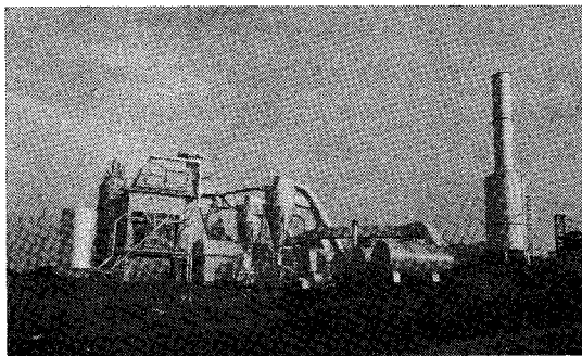
写真-5 三菱一日工 120t/h アスファルトプラント
