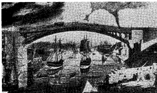
写真-2 サンダーランド橋(1793~1796年架設)
