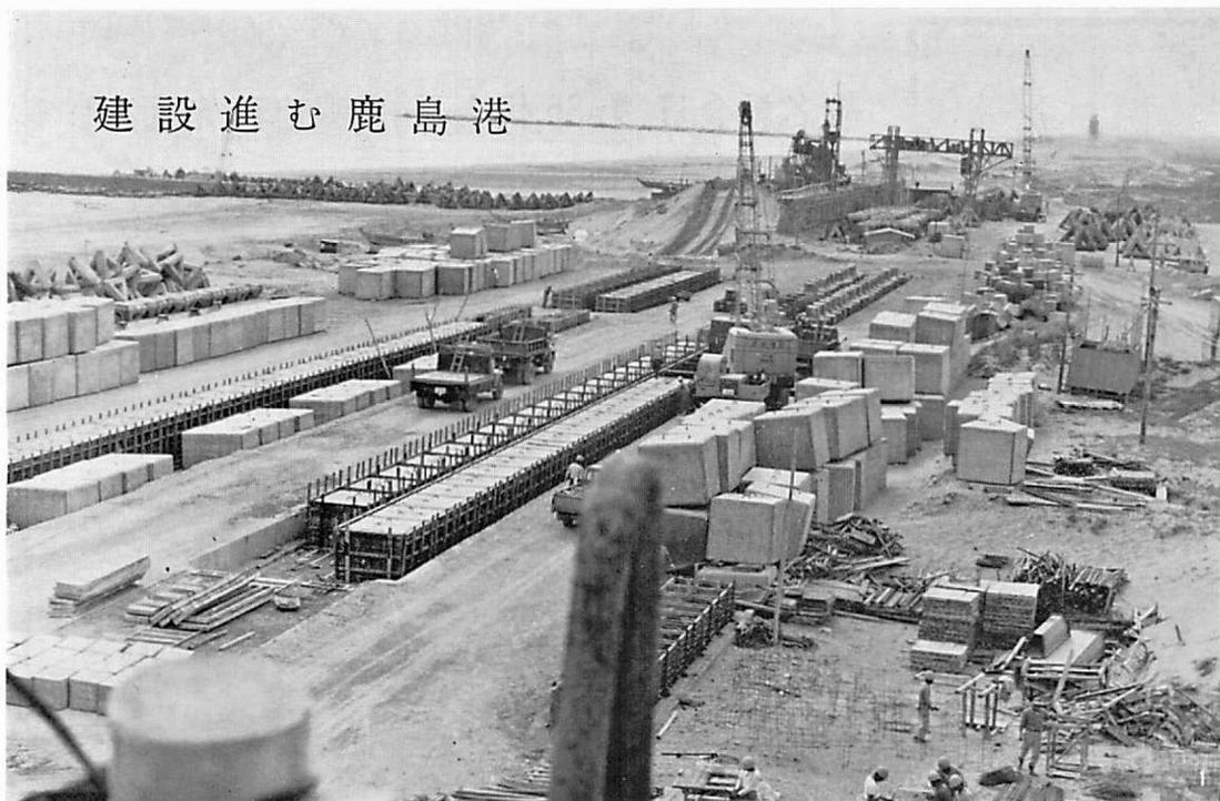
鹿島港は、東京から約 80 km 東方の鹿島灘海岸の広大な砂丘地帯に、全く新しい臨海工業地帯を建設するために計画された港であって、この鹿島臨海工業地帯の中核となる基本施設として昭和 38 年度から運輸省直轄工事として建設工事が始まっている。
