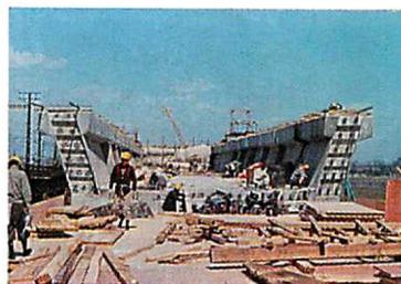
また桁下空高を確保するために、桁下端と軌条上面間距離は  $1.1\text{ m}$  をとった。このため、床版厚  $0.5\text{ m}$  の特殊設計による複線下路PC桁が、側径間に採用された。
