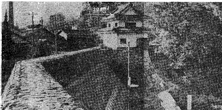
写真一 肱川特殊堤と葎綿櫓
