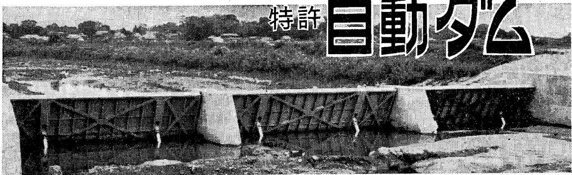
熊本県 行未川長洲堰 下軸油圧型(頭部リンク式)自動ゲート(2.33H×28.0B)
