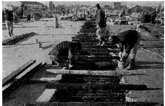
写真一5 高分子材料による橋梁スラブの補修 (新潟市昭和大橋)
