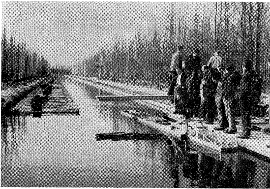
写真一 デルフト水理研究所の野外実験場（船舶の運航が運河の護岸におよぼす影響についての実験）
