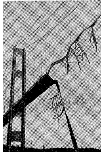
写真-3 Tacoma Narrows 橋は 1940年に開通後4か月目に毎秒 19m の風で崩落した
