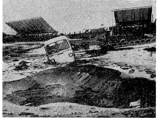
写真-2 新潟国立競技場の噴砂孔
