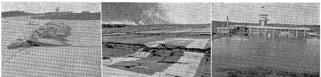
新潟空港被害写真・左よりA滑走路，B滑走路の破損状況，右はターミナルビルの沈下状況
