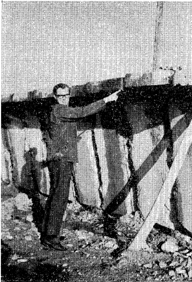
写真-13 Sabadell の PC 橋 (架設中)
