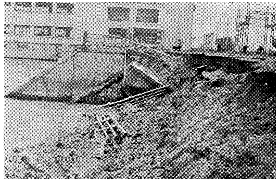
写真一七 ポンプ場付近のよう壁崩壊
