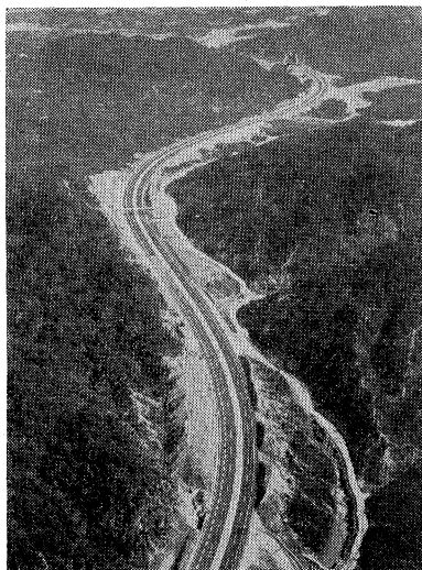
写真一 クロノイド曲線をみせる名神高速道路 滋賀県竜王町八重谷付近
