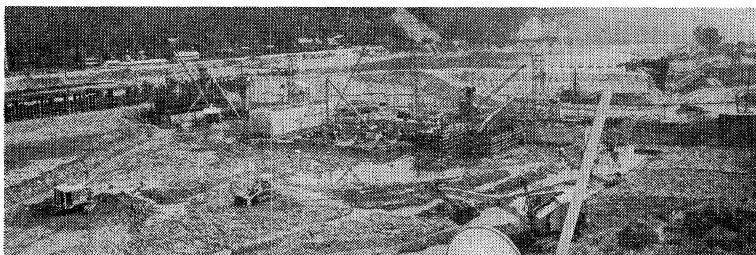
写真-1 基礎掘削工事に着手した阿賀野川用水農業水利事業阿賀野川頭首工
