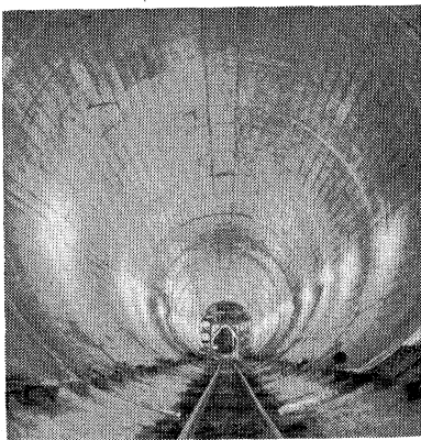
写真-2 放水路水圧トンネル
