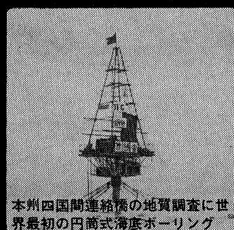
本州四国間連絡橋の地質調査に世界最初の円筒式海底ボーリング
