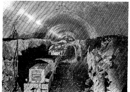
工事中の 新生駒ト ンネル
