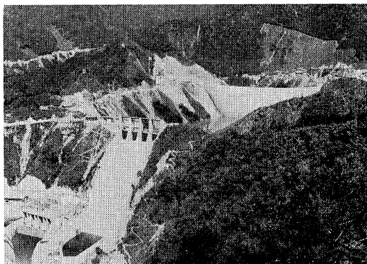
池原発電所と池原ダム
