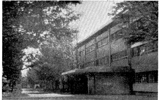
建設研修センターの外観
